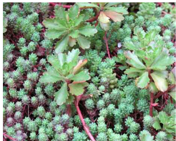
Bouw sedumdak, april 2014
